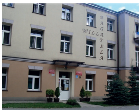
Budynek internatu po termomodernizacji
